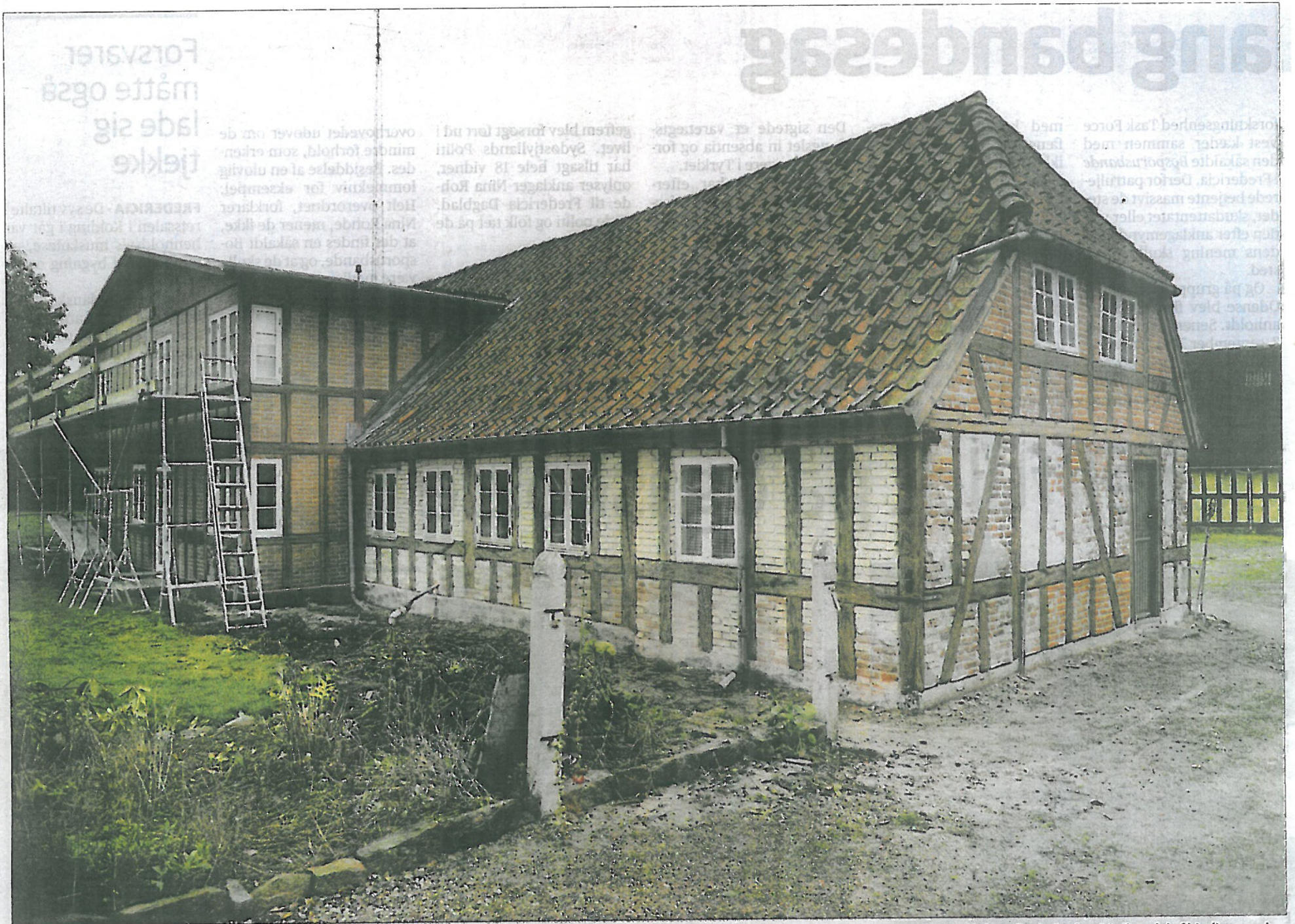
I dag kan det være svært at få øje på, at Tvedgaard er en historisk perle ved Rands Fjord. Facaden er sandblæst for at afdække de oprindelige materialer, og i løbet af et halvt års tid vil en del af bindingsværk og mursten være udskiftet og ejendommen fremstå som dengang i 1800-tallet.
